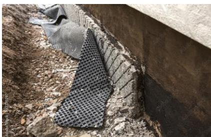
**Schwarzanstriche**, welche der Abdichtung von Kelleraußenwänden gegen Feuchtigkeit dienen, wurden früher oft auf Teerölbasis hergestellt. Die in den Voranstrichen enthaltenen **PAK's** und **Phenole** können tief in das dahinterliegende Mauerwerk eindringen und entsprechende Schadstoffbelastungen hervorrufen, welche eine Verwertung des Mauerwerks ausschließen.
