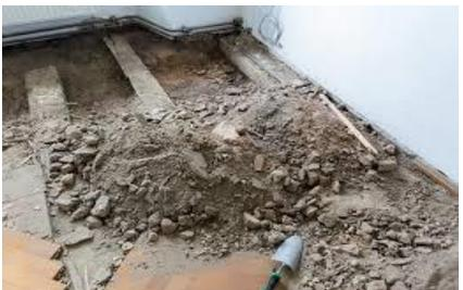
In Altbauten wurden früher häufig **Fehlbodenschüttungen** aus **schwermetallhaltigen** Schlacken verwendet. Unter Umständen können in den Schüttungen auch **radioaktive Substanzen** verborgen sein (z. B. Radon).
