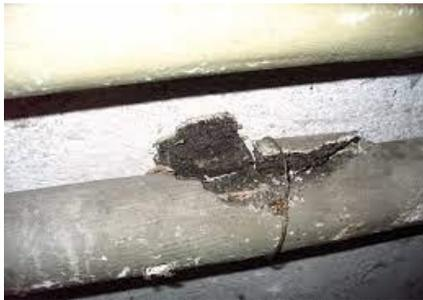
**Teerkork** ist ein Korkgranulat, das mit einem teerhaltigen Bindemittel verklebt wurde. Als Isolierungsplatten und Rohrschalen war Teerkork weit verbreitet >> **PAK's** und **Phenole**.
