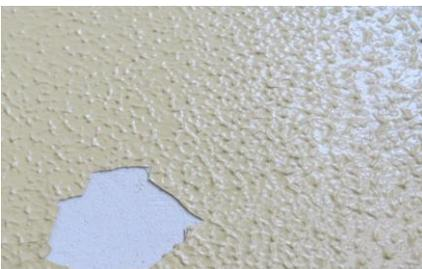
**PCB-haltige Anstriche** wurden in Innenräumen bspw. für bestimmte Akustik-Wandpaneele, Bodenbeläge oder Stalungen verwendet. Das Ausgasen von **PCB** führt zu einer Raumluft- und Lebensmittelkontamination.
