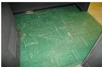
In Altbauten der 1950er bis 1970er Jahre wurden oftmals **asbesthaltige PVC-Bodenbeläge**, sog. **“Floor-Flex-Platten“**, **“Vinyl-Asbest-Fliesen“** oder **“Cushion-Vinyl-Beläge“**, verbaut.
