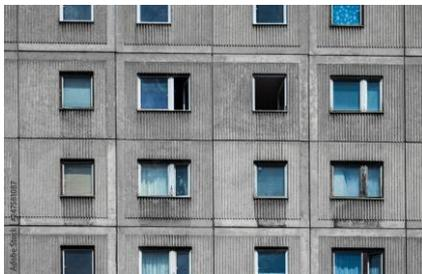
**PCB-haltige Dichtungsmassen** wurden beim Verfugen von Plattenbauten der 1970er Jahre oder in Altbauten ab den 1950er Jahren als elastische Dichtungen für Beton-Stahl-Verbindungen, Fenster- und Fertigelemente sowie Rohrdurchführungen verwendet. Die damals eingesetzten Stoffe haben sich als gesundheitsgefährdend herausgestellt, da sie z. T. große Mengen **PCB** (Polychlorierte Biphenyle) enthalten, welche als krebserregend gelten.
