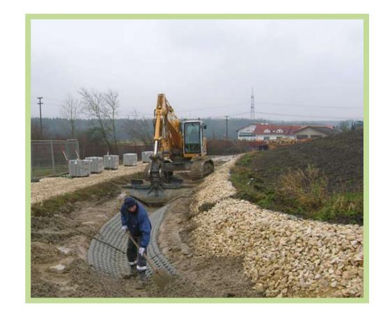
Herstellung des Deponierandgrabens zur Ableitung des Oberflächenwassers
