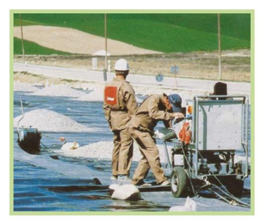
Verschweißen der überlappenden Dichtungsbahnen
