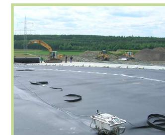
Verlegung der Kunststoffdichtungsbahn
