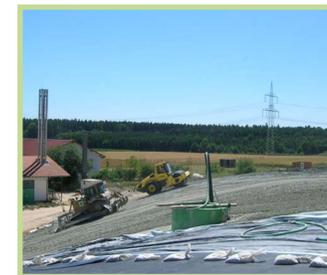
Einbau der mineralischen Dichtungsschicht
