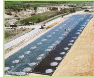
Aufbringen des Sandauflagers und der Kunststoffdichtungsbahnen
