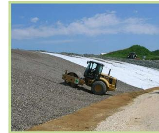
Herstellung der gasgängigen Ausgleichsschicht
