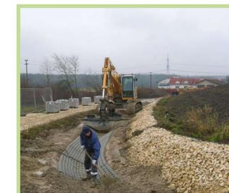
Herstellung des Deponierandgrabens zur Ableitung des Oberflächenwassers
