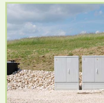
Schaltanlagen für Dichtungskontrollmessungen
