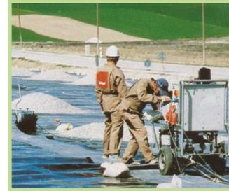
Verschweißen der überlappenden Dichtungsbahnen
