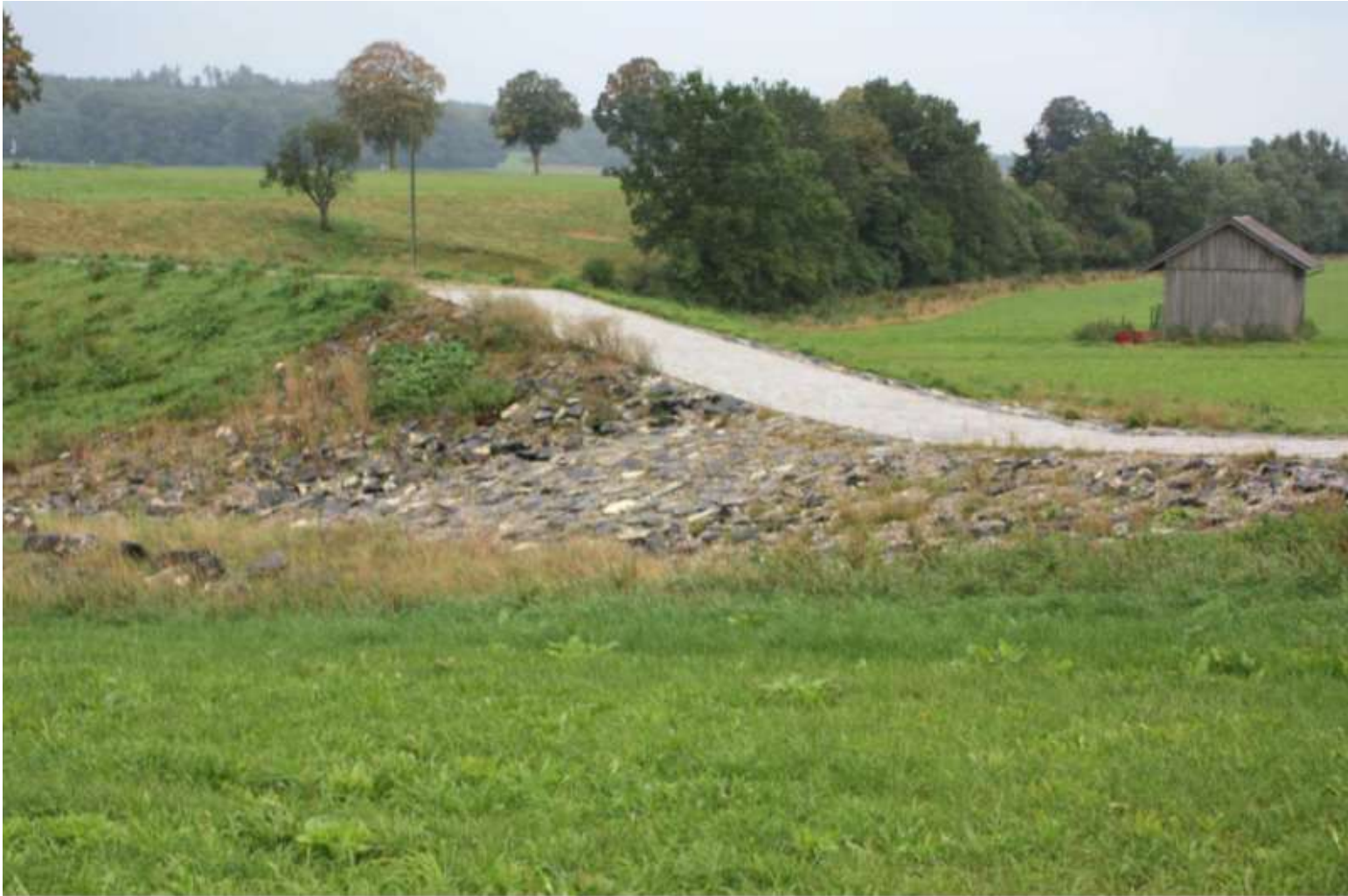
Überlaufscharte (Hochwasserentlastung) am Damm
