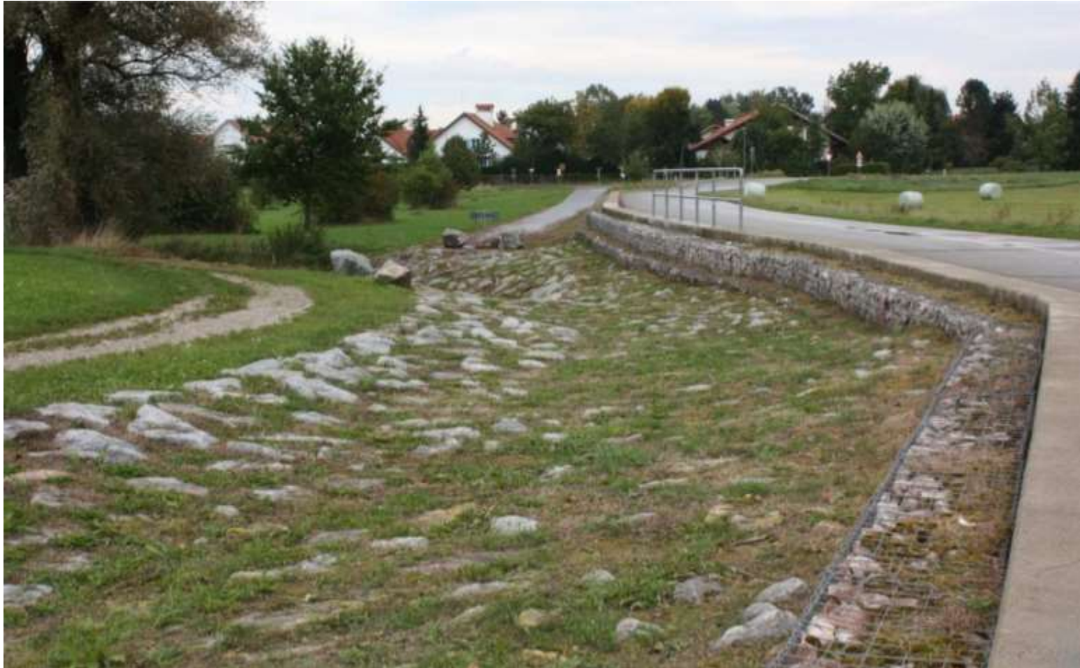
Leitdamm an einem Radweg
